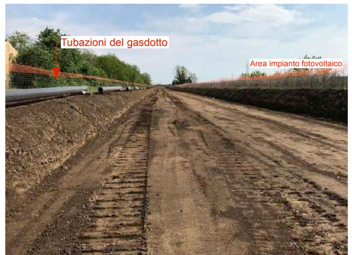
Lavori precedenti agli scavi per il posizionamento delle tubazioni del gasdotto
